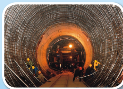
穿黄隧洞二次衬砌
