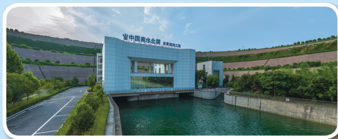
穿黄工程南入口近景
