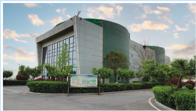
穿黄工程北岸建筑物
