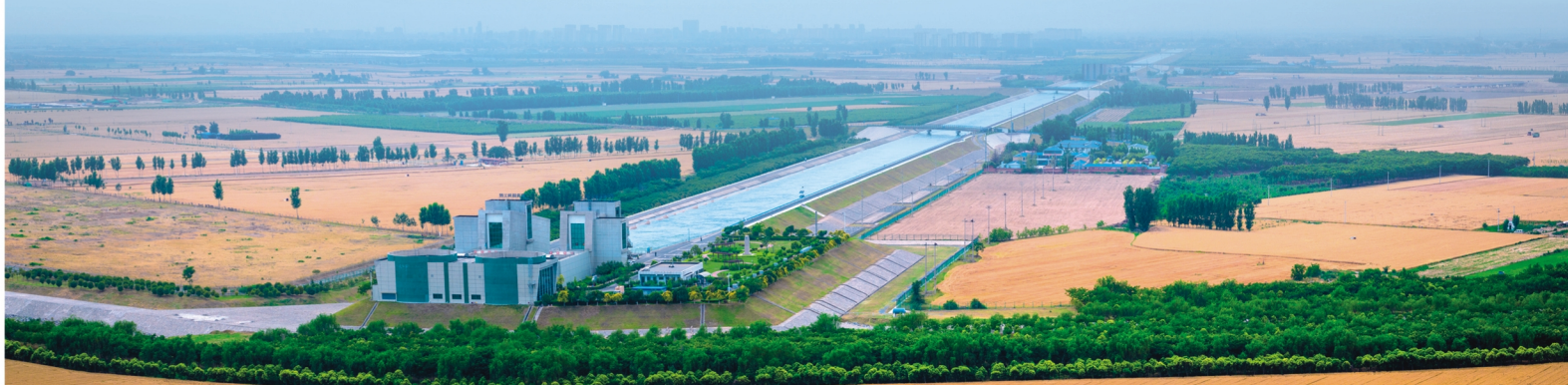
穿黄工程北出口俯瞰
